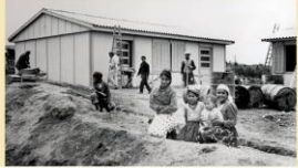
Un centre social en construction dans un bidonville.
